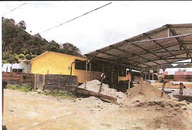
Foto 1: Mejoramiento de estructura tipo pórtico e instalación de lámina troquelada calibre 26, en patio 1
