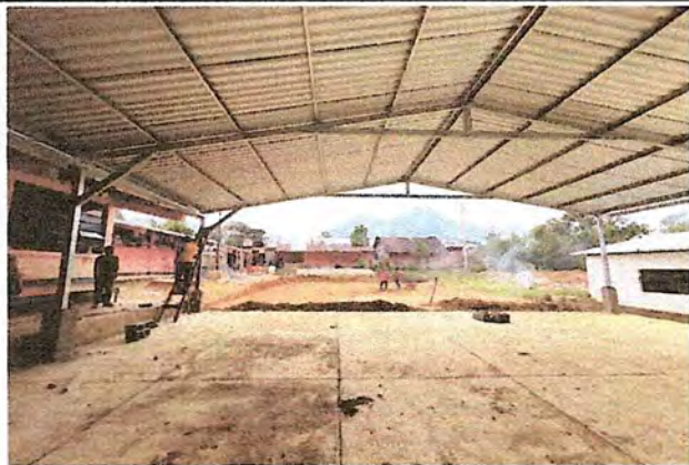
Foto 1: Mejoramiento de estructura tipo pórtico e instalación de lámina troquelada calibre 26, en patio 1
